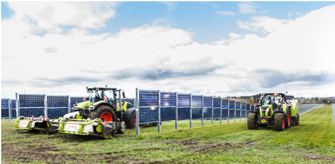
**Abb. 15: Beispiel einer vertikalen Freiflächenanlage mit Bionutzung (Quelle: Next2Sun)**
